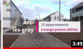
Habitat 70 : Logements BEPOS à Arc-lès-Gray (70)
