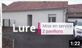
Habitat 70 : 2 nouveaux pavillons à Lure
