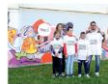
Fresque sur l'immeuble prévu à la déconstruction rue de l'Europe à Gray.
